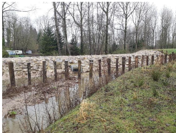
Photo 6 - Buse et déversoir avec capteur hydrométrique
