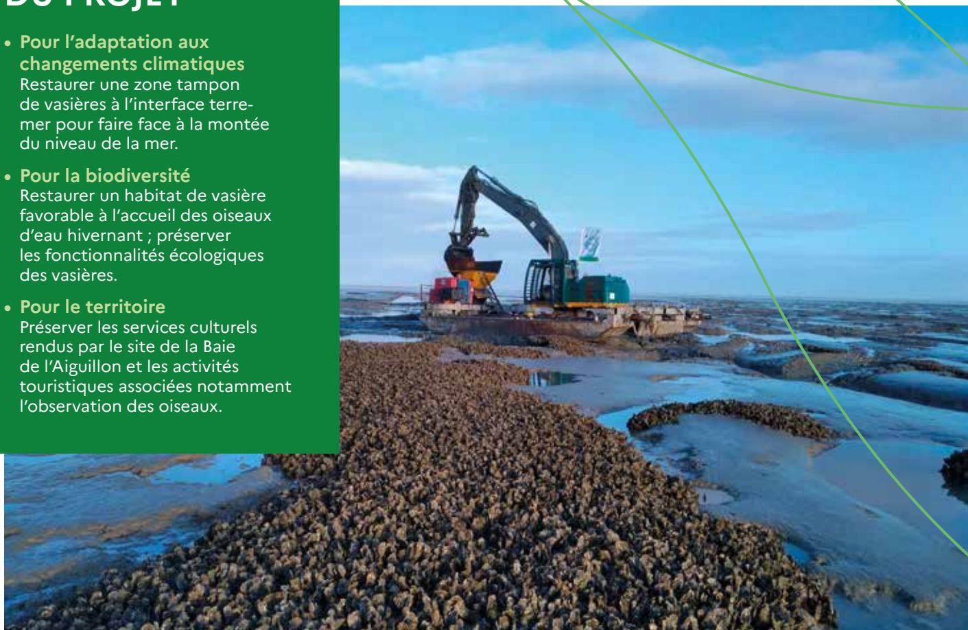
Machine innovante (première version) en train d'enlever les crassats d'huîtres sauvages japonaises, 2019 © RNN Baie de l'Aiguillon
