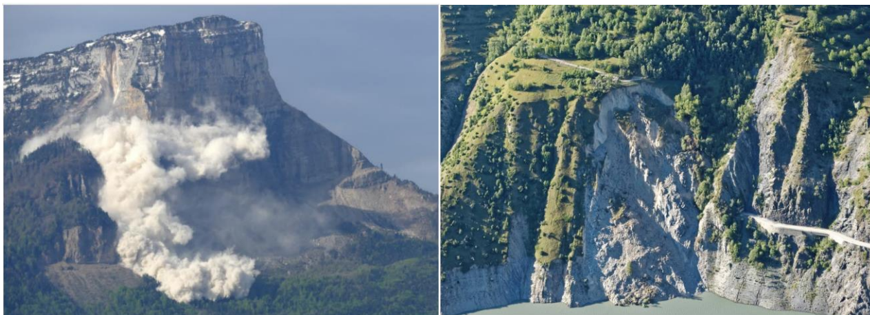
Figure 7 : Exemples de catastrophes gravitaires en AuRA : (1) Éboulement du Mont Granier du 7 mai 2016 / (2) Glissement du Chambon (actif depuis 2015) Source : ORECC, 2017
