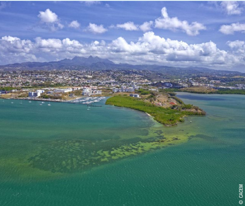
Projet d'expérimentation d'une solution basée sur la mangrove pour la protection du port de plaisance de l'étang Z'Abricots à Fort-de-France.
