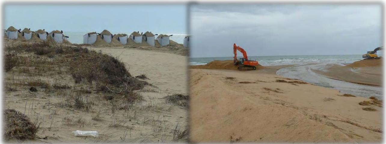
Figure 38 : Pose de big-bags pour fermer la passe du secteur des Violettes et pelles mécaniques en action pour fermer une autre passe en recréant un cordon dunaire ex nihilo.
