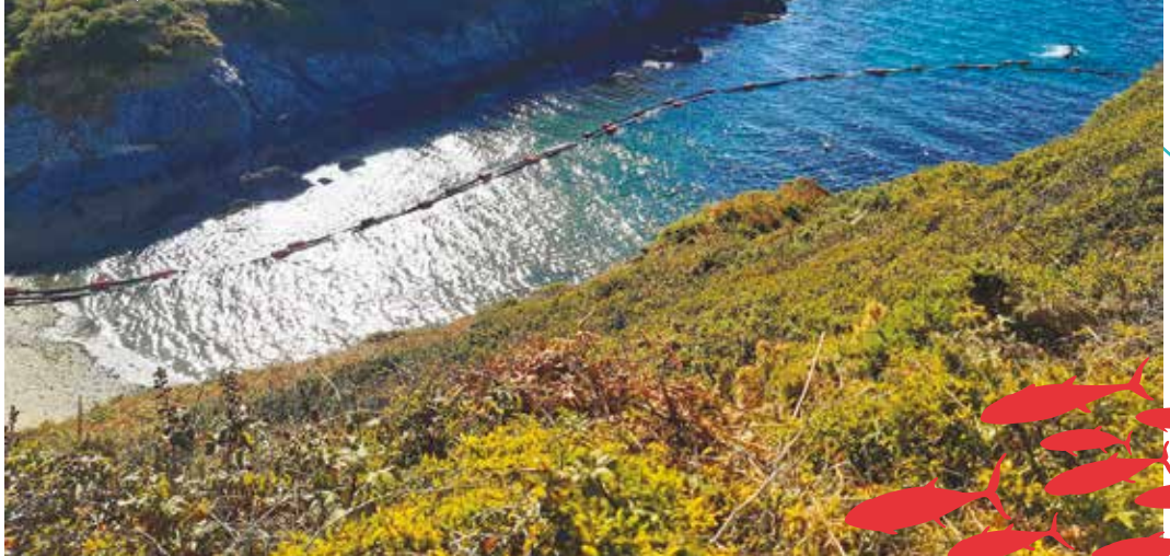
Point de pompage en mer pour l'alimentation de l'usine de dessalement d'eau de mer à Groix (56) © Hélène Anquetil / OFB
