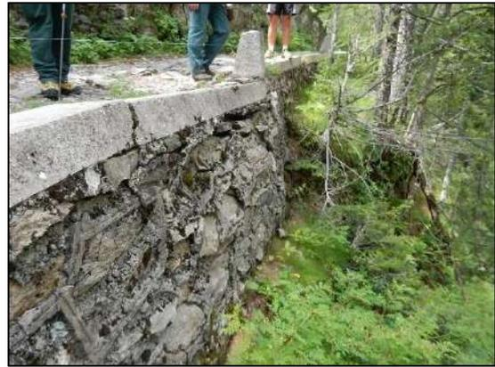
*Déformation et fissuration*
