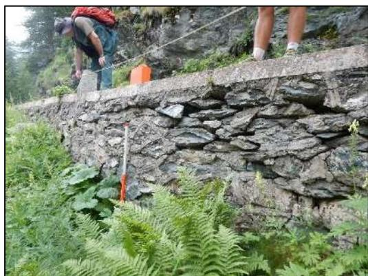
*Dégradation du jointolement de maçonnerie*
