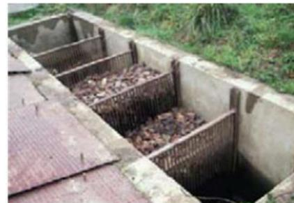
Filtre fixe installé sur une eau close (hors d'un cours d'eau)
