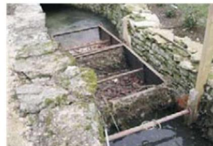
Filtre mobile installé sur un cours d'eau
