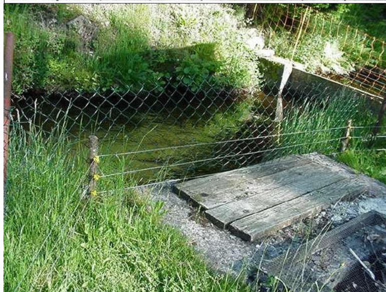
Figure 8 : Clôture électrique doublée d'un grillage torsadé (LEBLANC 2001).
