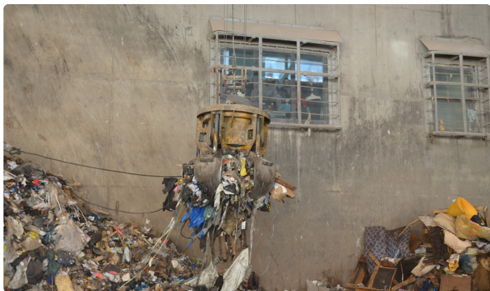
L'usine, unité de valorisation énergétique des déchets, a débuté son fonctionnement en 1998.
