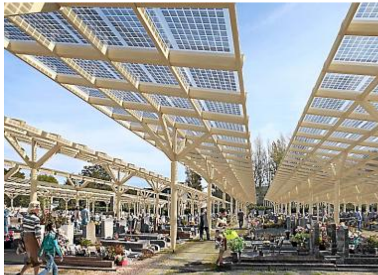
5 000 panneaux photovoltaïques seront installés. PHOTO VILLE DE SAINT-JOACHIM
